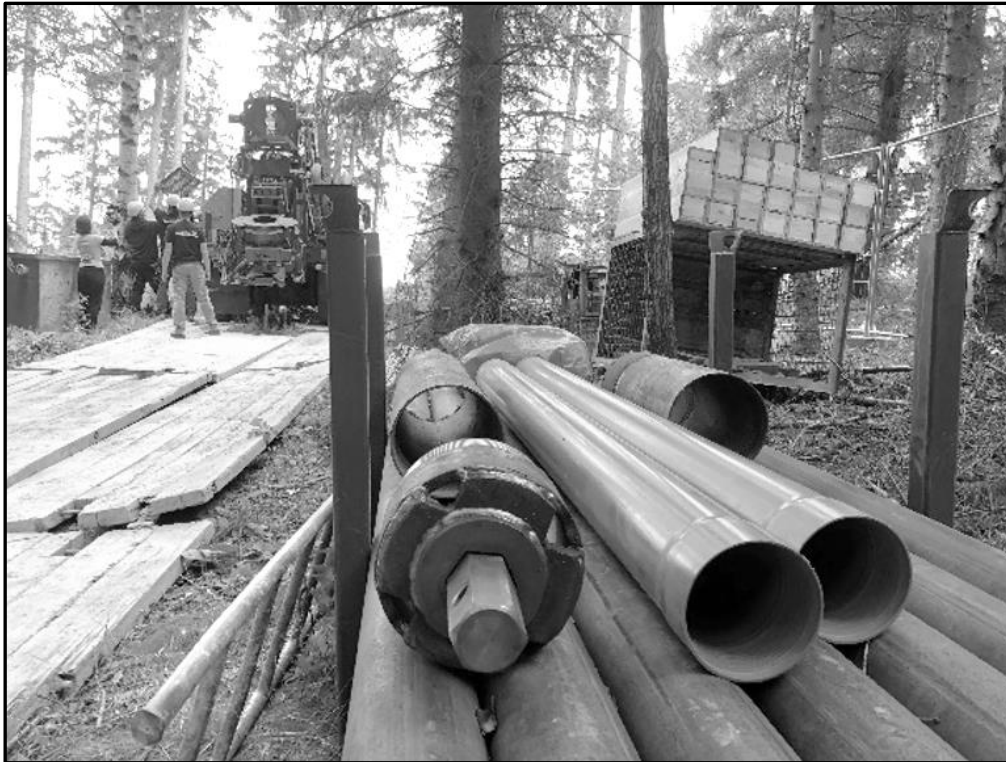
Abb. 1: Vorbereitung der Bohrstelle mit Auslegung von Bohlen.
