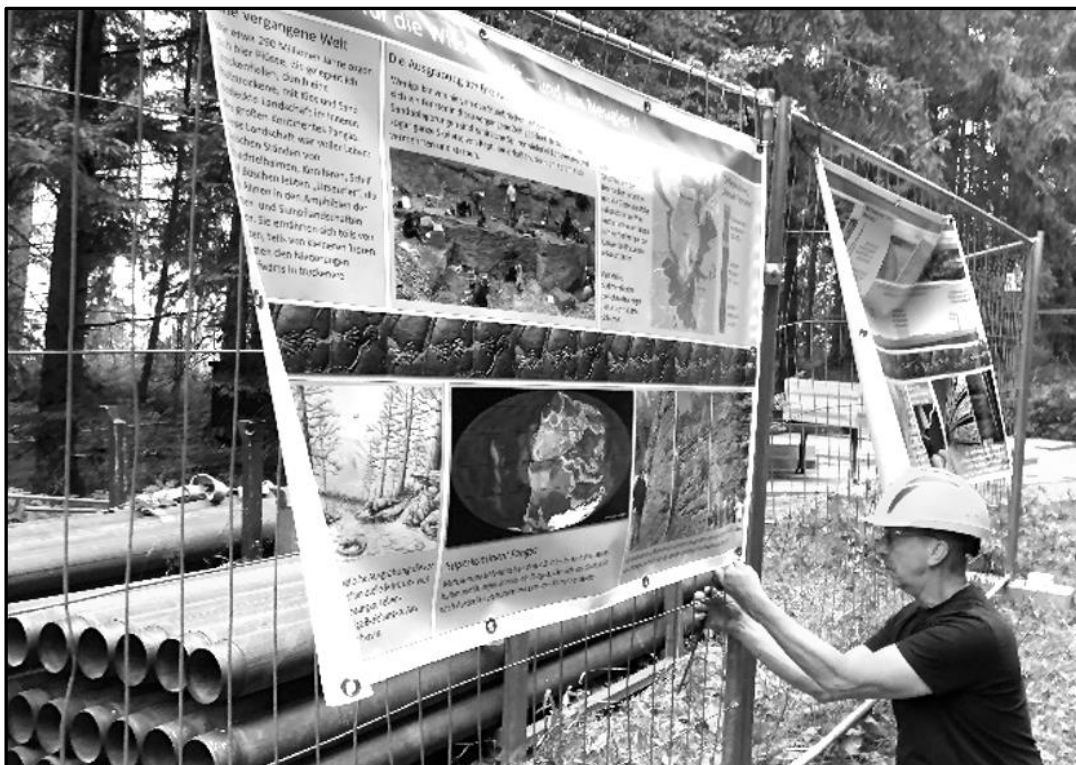
Abb. 4: Erklärende Poster werden am Bauzaun angebracht.
