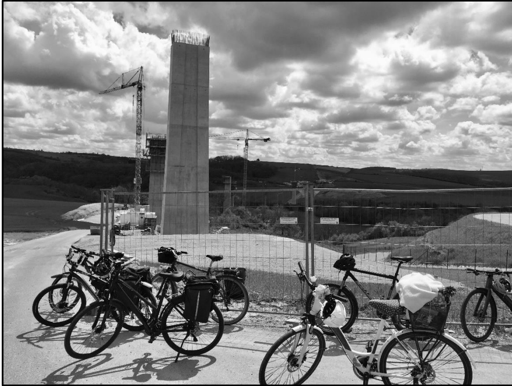
Abb. 6: Baustelle der Talbrücke über die Saale bei Stendorf.
